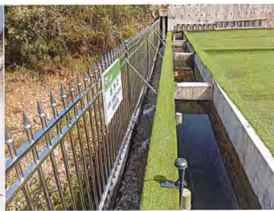
废水处理站出水
