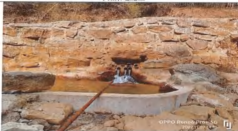
矿洞涌水收集池
