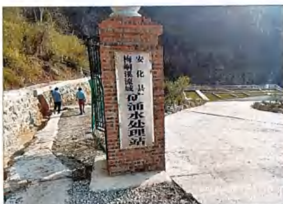
废水处理站进场大门
