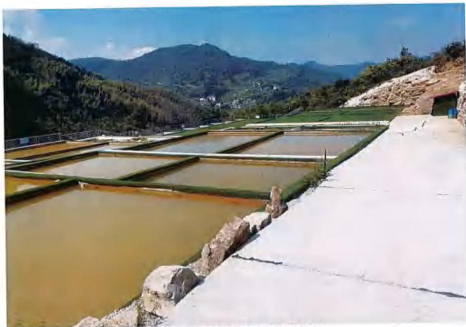
水处理系统实际建设情况
