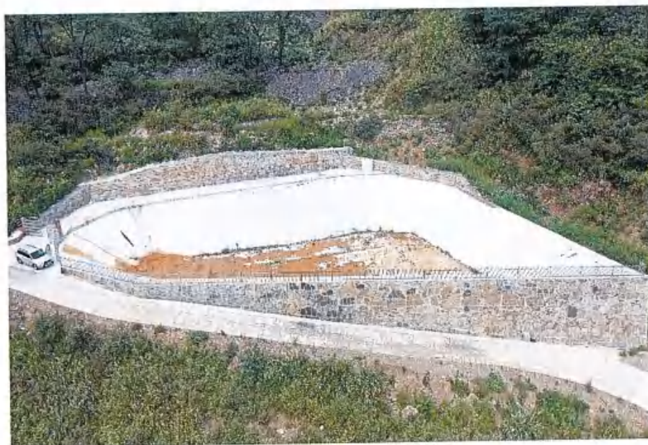
污泥暂存池实际建设情况
