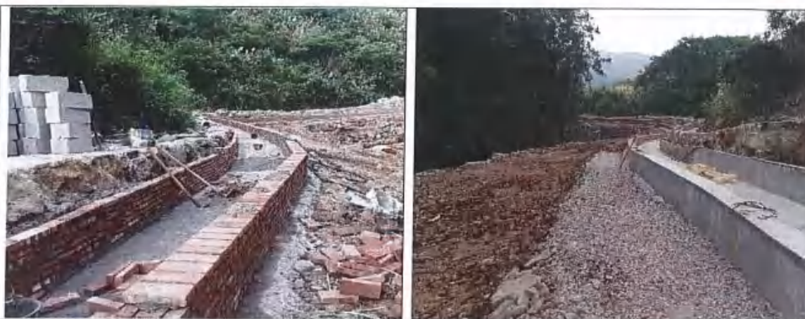
导流渠道施工
