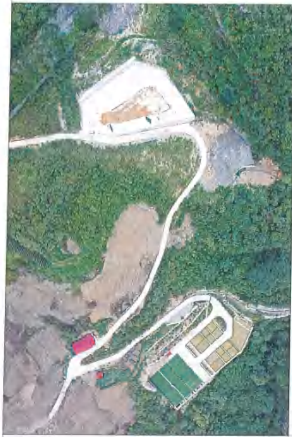
废水处理系统现状
