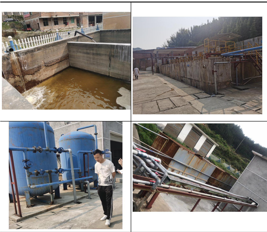
图 5.4-2 现有 污水处理厂现场照片
