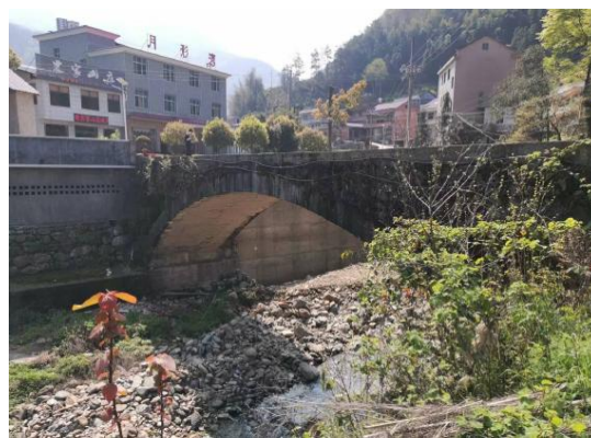
龙溪小桥现状
